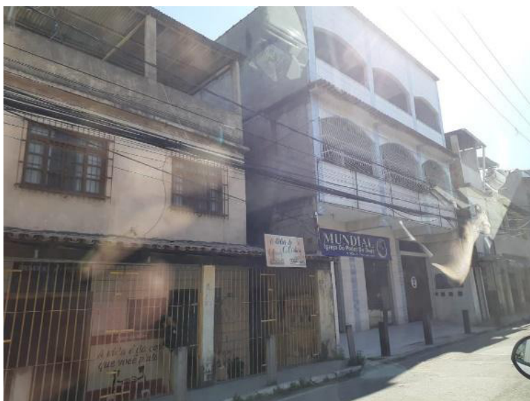
Figura 2: Fachada de residências
